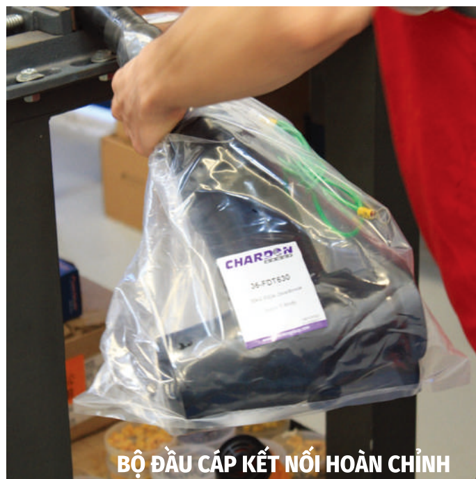
LẮP ĐẶT ĐẦU CÁP
