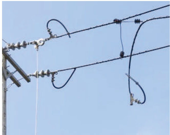
Dây hỗ trợ giữ cố định dây điện, ngăn không cho dây rơi xuống đất.
