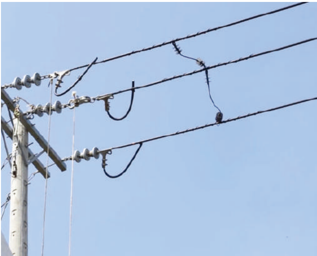
Dây hỗ trợ chống rơi được gắn vào các dây điện trên không.
